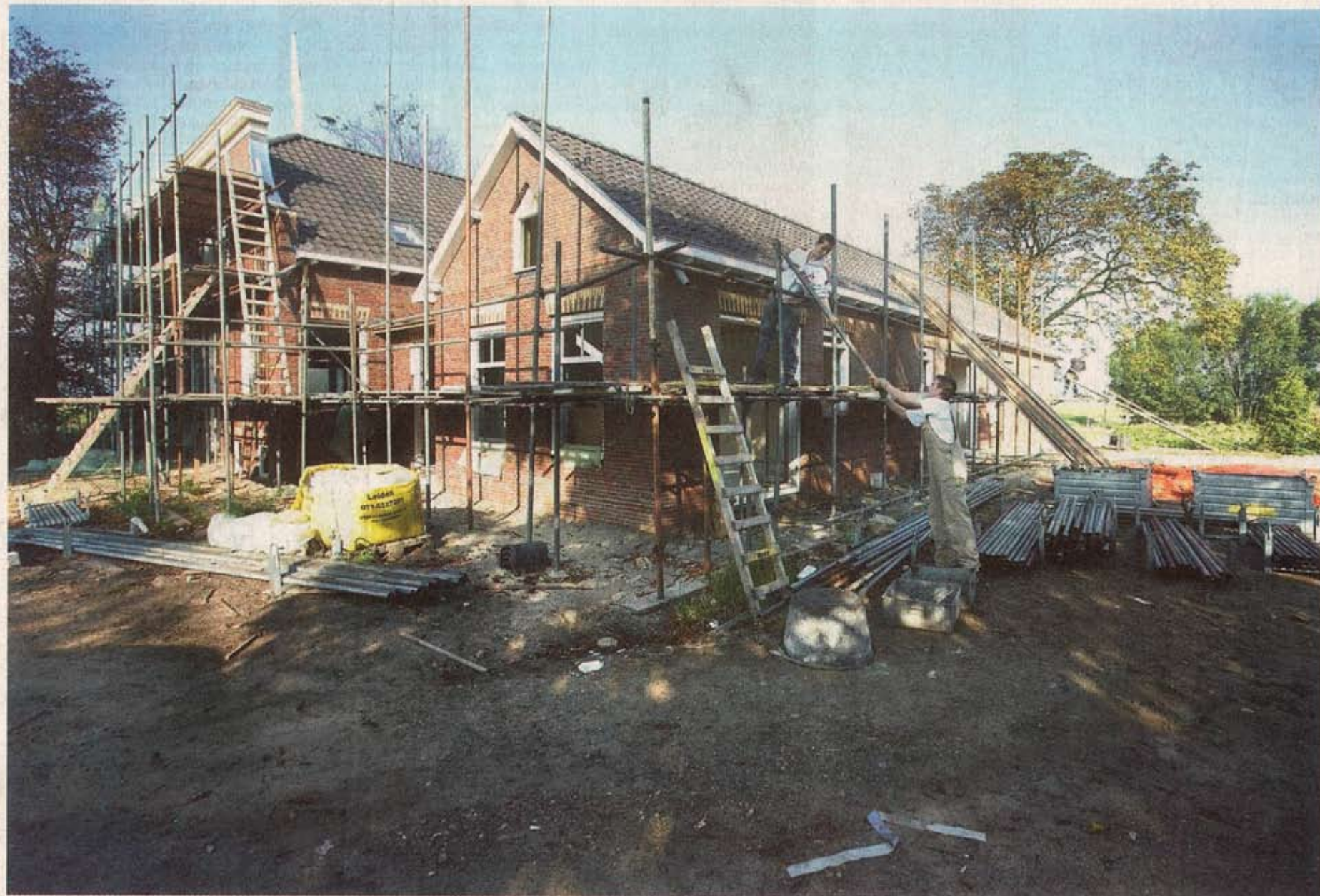
Hoeve Teijlingenhof is al zo ver klaar, dat de bouwsteigers geleidelijk aan afgebroken kunnen worden.
